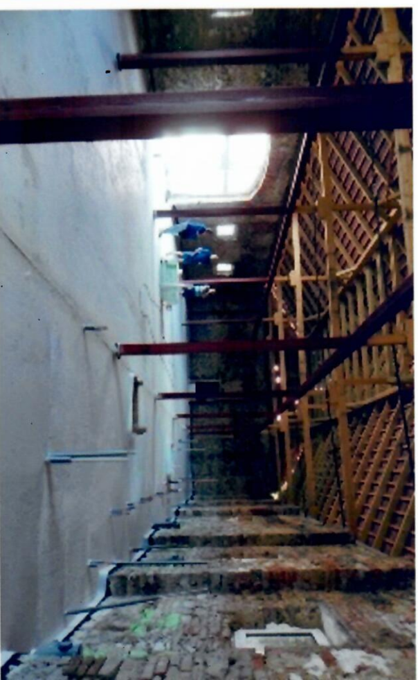
Kontrolní den, osazeny rozvody sítí
